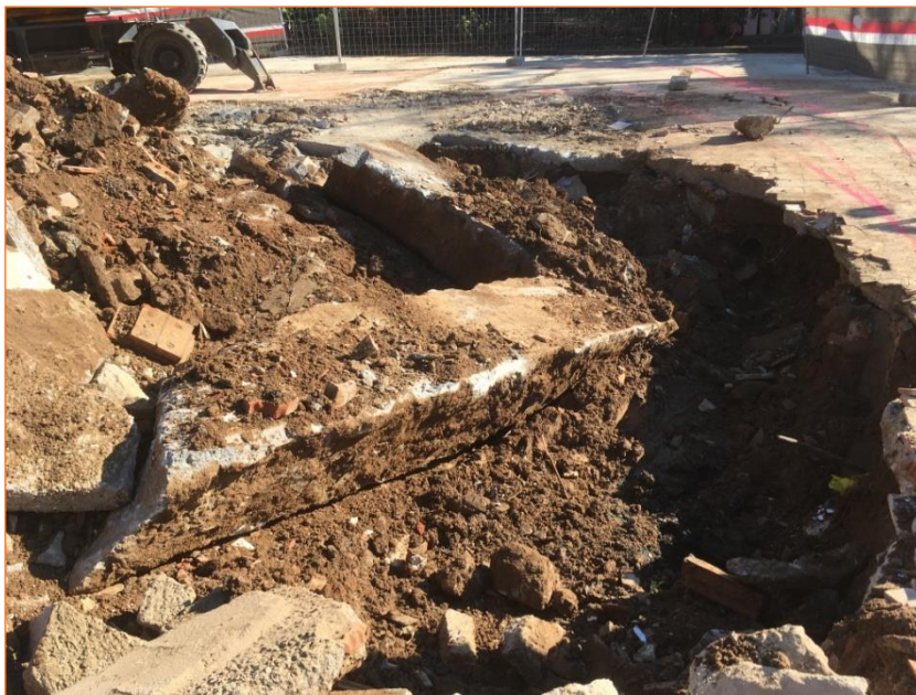
Foto 32. Vista de l'excavació a la zona de l'estany, UE 2 i fonamentacions.
