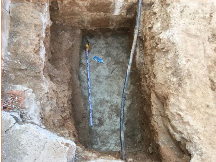
Foto 17. Vista del nivell UE 19 i part de la fonamentació del mur UE 15.
