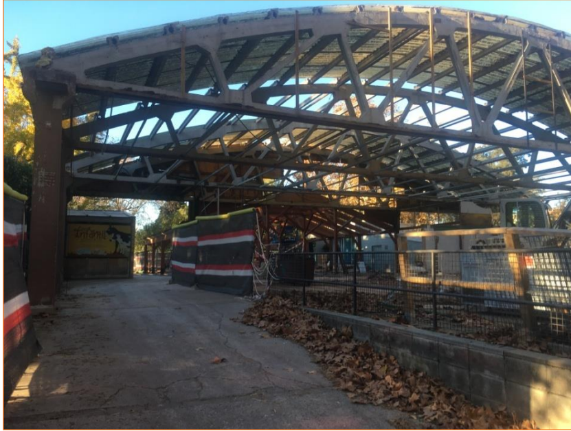
Foto 1. Vista inicial abans de començar els rebaixos al subsòl.
