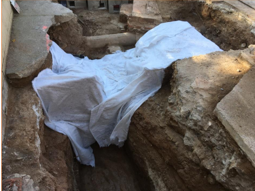
Foto 21. Vista del mur UE 15 un cop col·locat el geotèxtil.
