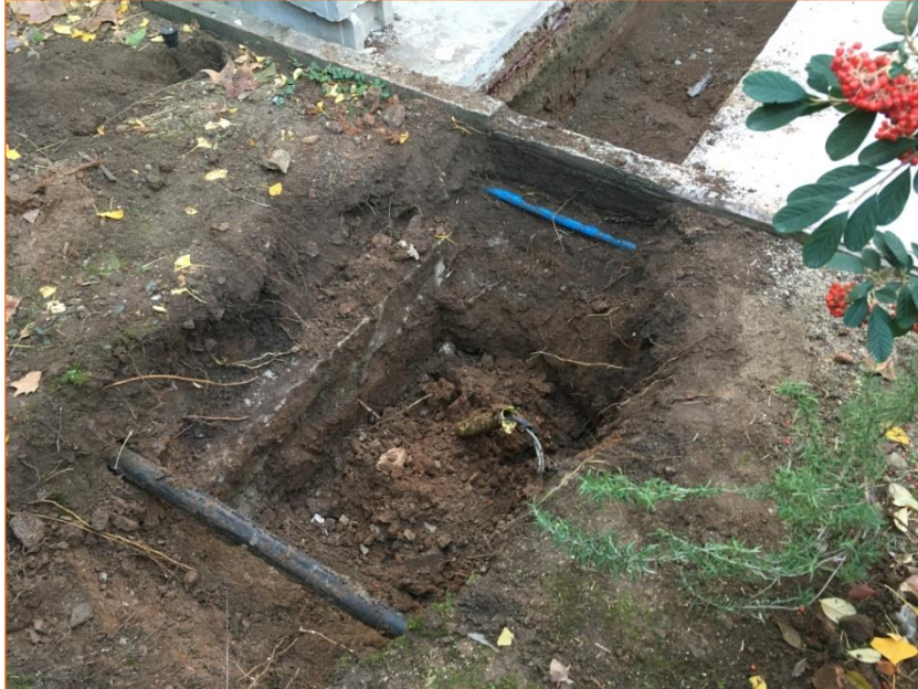
Foto 27. Vista de la rasa en la part enjardinada i dels tubs de serveis.
