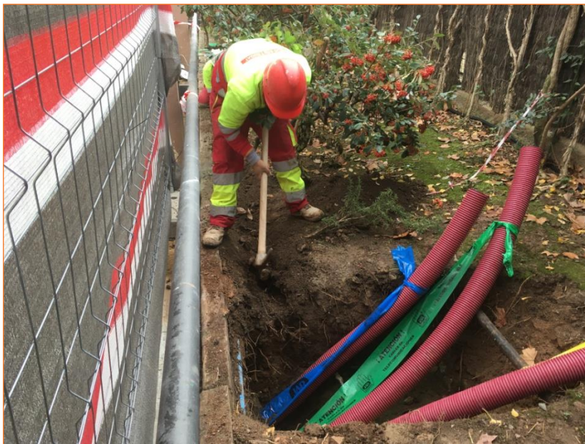
Foto 28. Vista de l'obertura de la rasa de telecomunicacions en la zona enjardinada.
