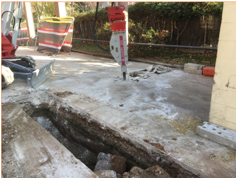
Foto 26. Vista de l'obertura de la rasa de telecomunicacions davant del paller.
