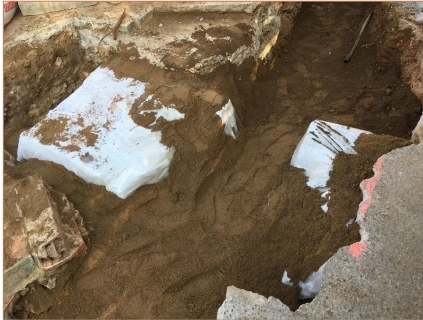
Foto 23. Vista del mur UE 15 un cop fet el llit de sauló.
