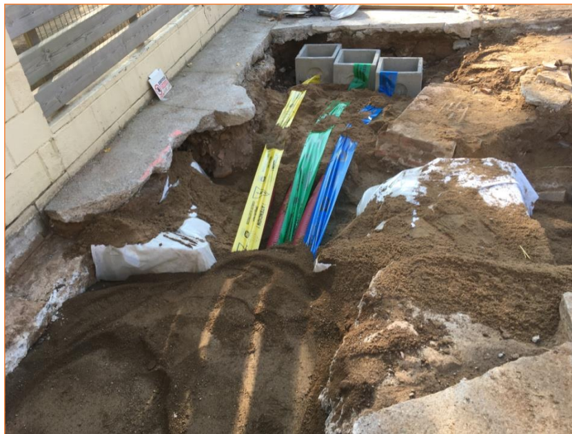
Foto 24. Vista del mur UE 15 un cop col·locat els tubs i llur senyalització.
