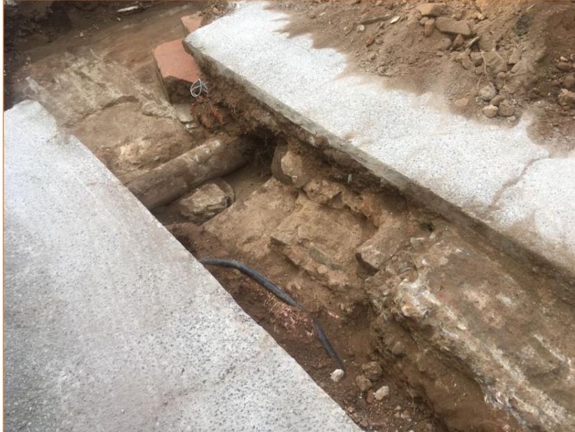
Foto 9. Vista del soterrani (UE 13), mur (UE 15) i fonamentació (UE 11).
