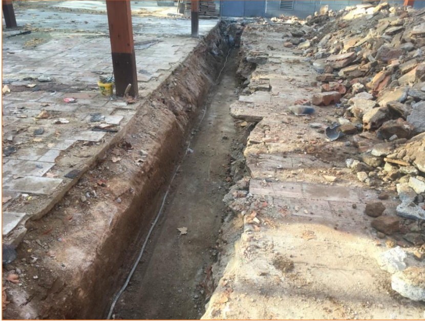
Foto 5. Vista del col·lector UE 6, en el primer tram de la rasa.
