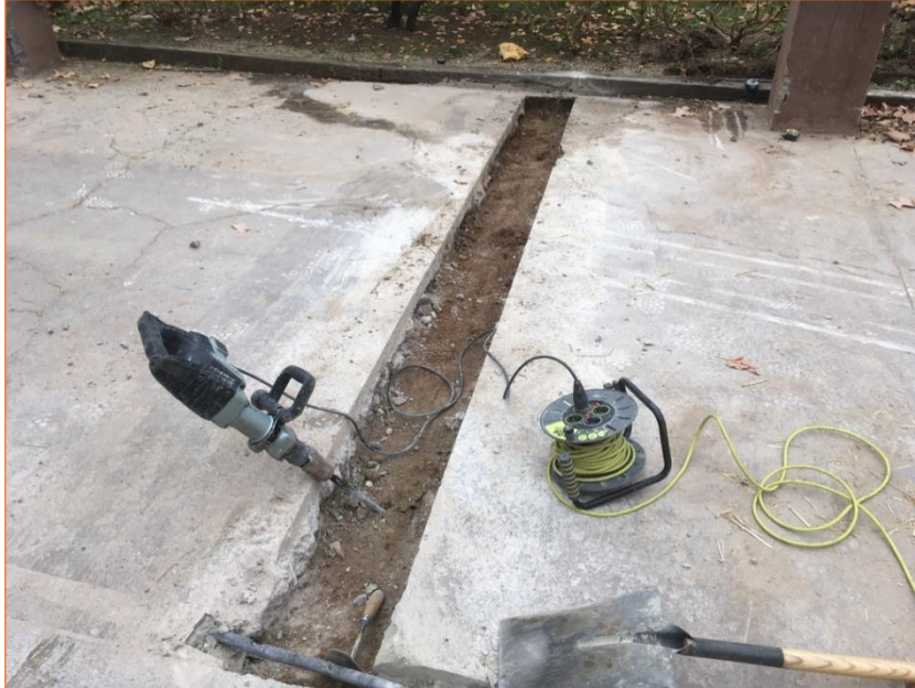
Foto 29. Vista de la rasa de telecomunicacions travessant el paviment UE 1.
