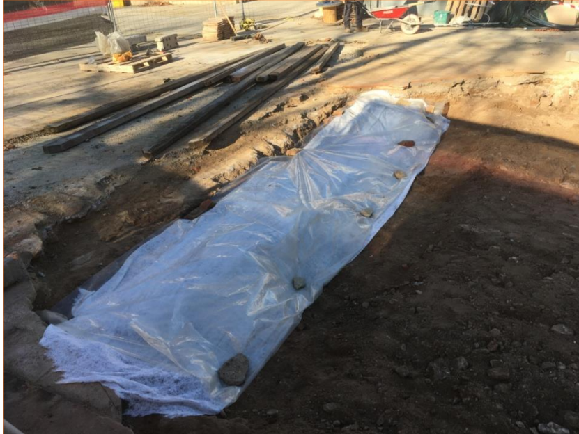
Foto 39. Vista del 2n tram del mur UE 15 amb el cobriment de geotèxtil i plàstic.
