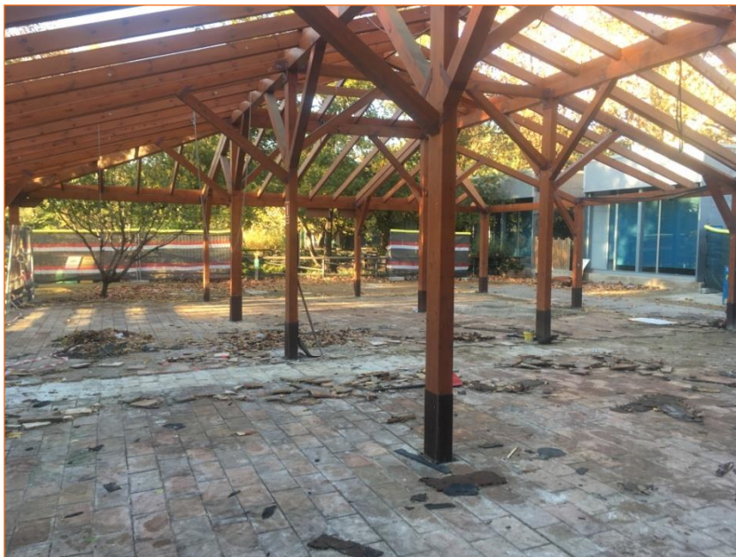
Foto 2. Vista inicial abans de començar els rebaixos al subsòl.
