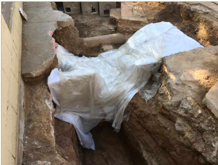
Foto 22. Vista del mur UE 15 un cop col·locat l'aïllament plàstic.
