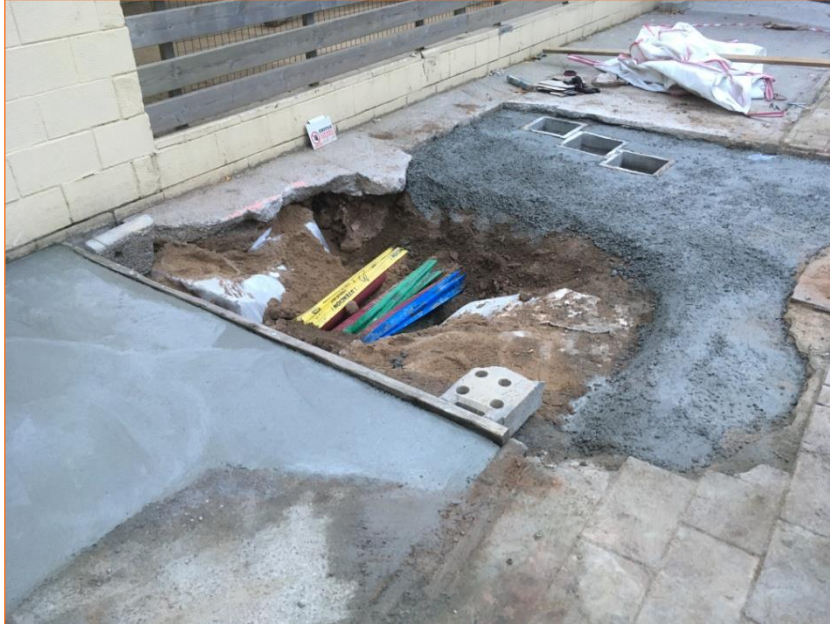
Foto 25. Vista del mur UE 15 un cop fet el paviment de formigó.
