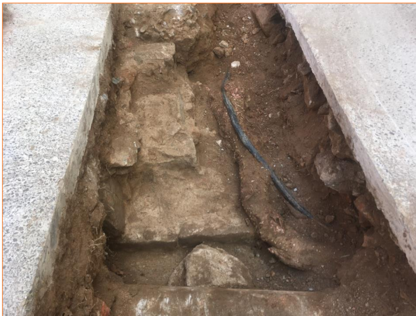
Foto 10. Vista del mur UE 15, dins la rasa inicial.
