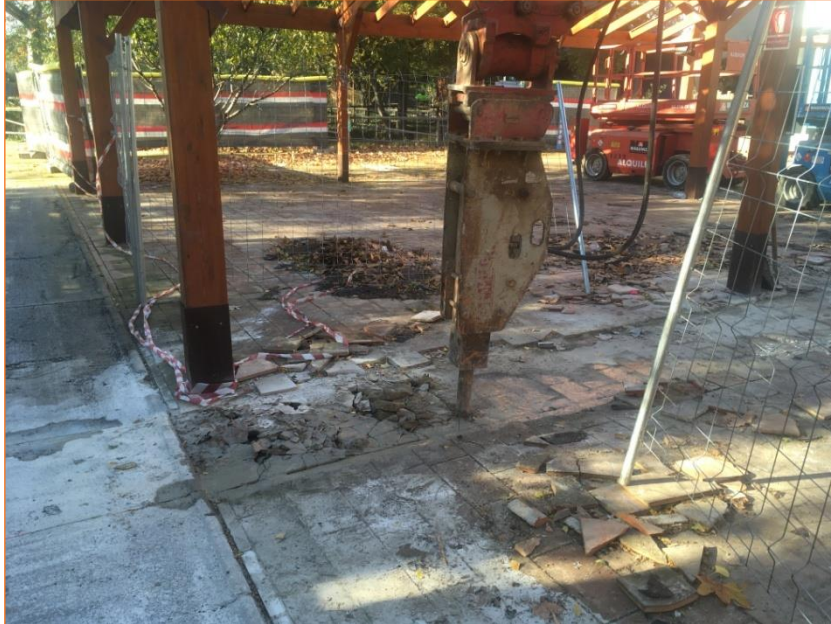
Foto 3. Vista de l'inici dels treballs, excavació mecànica del paviment UE 1.
